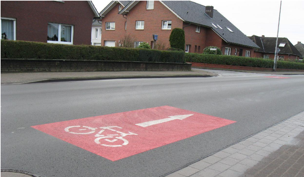
Abb. 7.4: Markierung von „Sharrows“ zur Verbesserung der Radverkehrsführung (Bsp. aus Dinklage)
